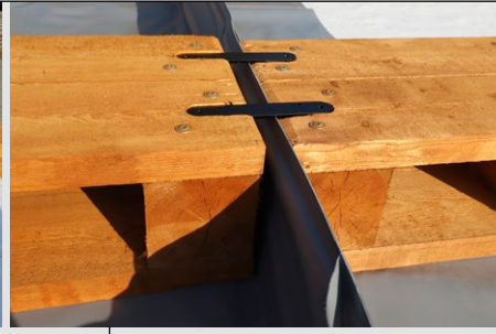
Detail ukotvení dřevěné rampy
